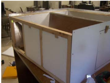
Figura 5: aislamiento del horno plano.
