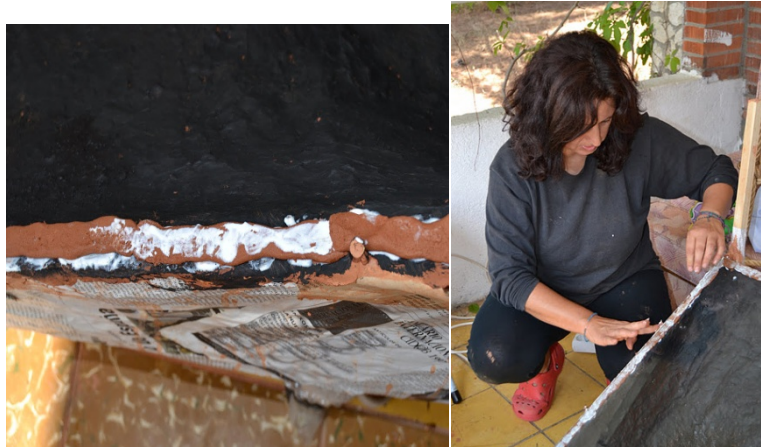
Figura 18: aplicación del cordón de barro, adobe de papel y cola para sellar el contacto con el cristal
