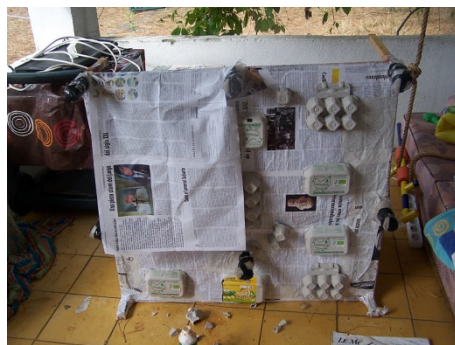
Figura 15: capas de aislante de papel
