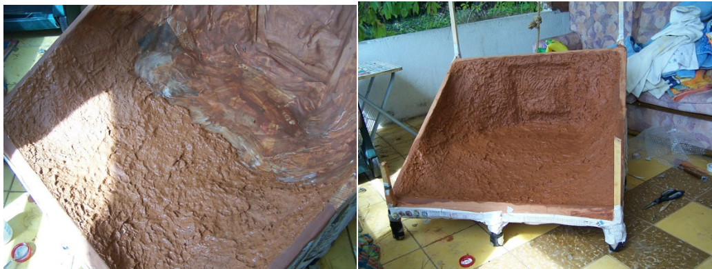
Figura 17: aplicación del adobe de papel al interior del horno
