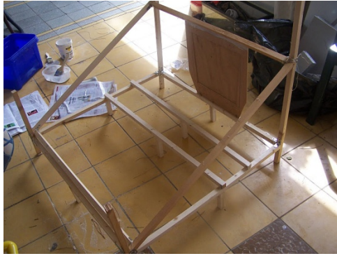
Figura 11: estructura interna del horno de papel y barro
